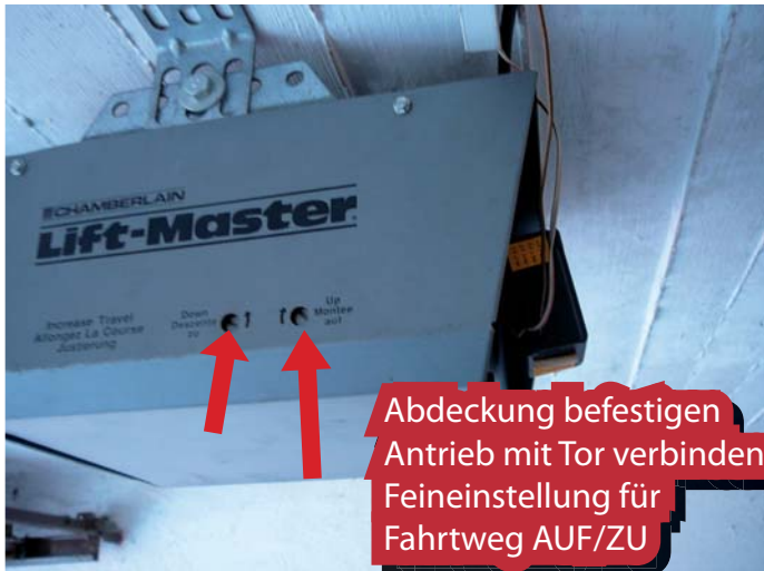
Krafteinstellung für AUF/ZU einstellen Nicht zu stark einstellen Tor sollte bei einem Widerstand revidieren
